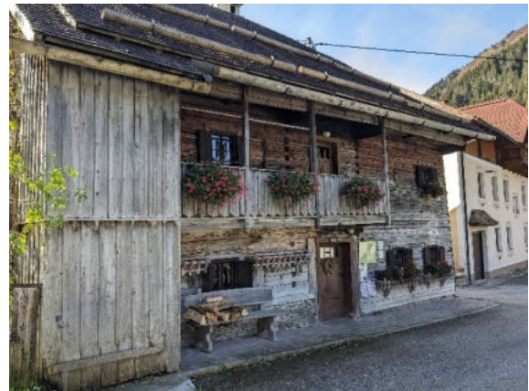
Abbildung 54: Mesnerhaus in St. Nikolai. Foto: © E.C.O.
